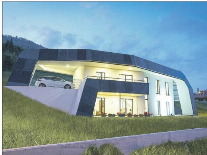
La vivienda de Sunthalpy está desconectada plenamente de la red eléctrica. ©
